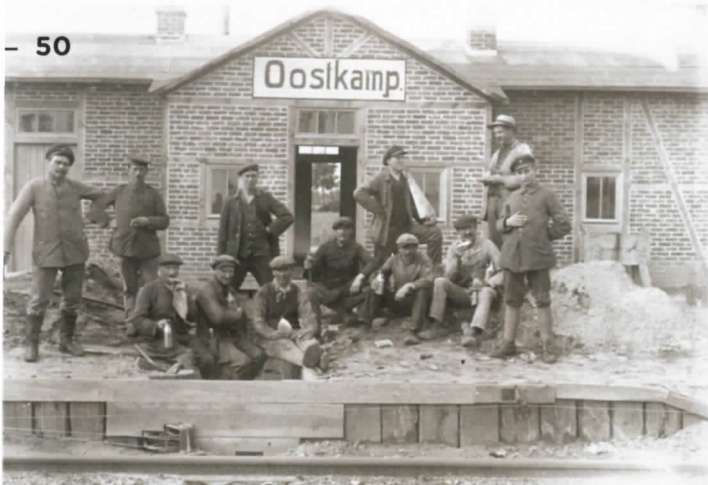
ill. 77 Het klein station of Kleinbahnhof dat door de Duitse bezetter bij het munitiedepot op de wijk Stuivenberge werd gebouwd.
