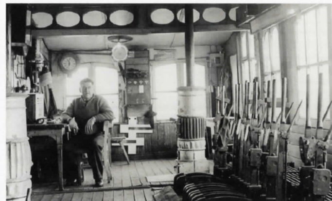
ill. 45 Beeld van het interieur van een Engels seinhuis waar de seinwachter de seinen en wissels bediende door middel van grote hendels. Dit was het eerste semi-geautomatiseerd seinsysteem genoemd naar haar Engelse uitvinder John Saxby. Dergelijk systeem werd ook in België geïntroduceerd.
