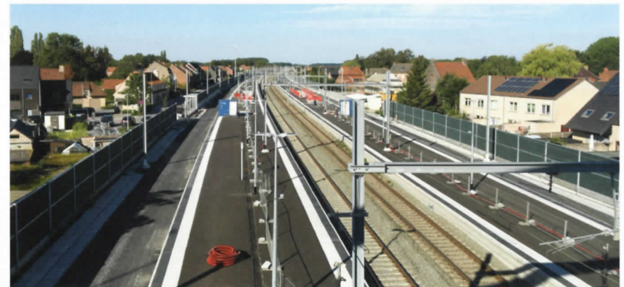
ill. 1 De site van het station na de aanleg van het derde en vierde spoor.
