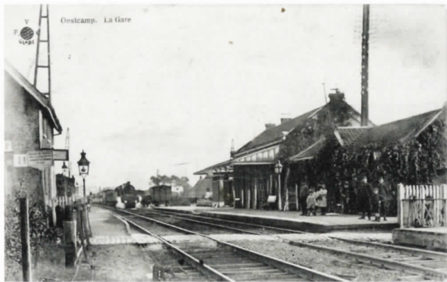
ill. 44 Deze postkaart geeft een mooi overzicht van de verschillende gebouwen op de stationsite. Opvallend is hier ook dat er wagons op de goederenkaai staan.
