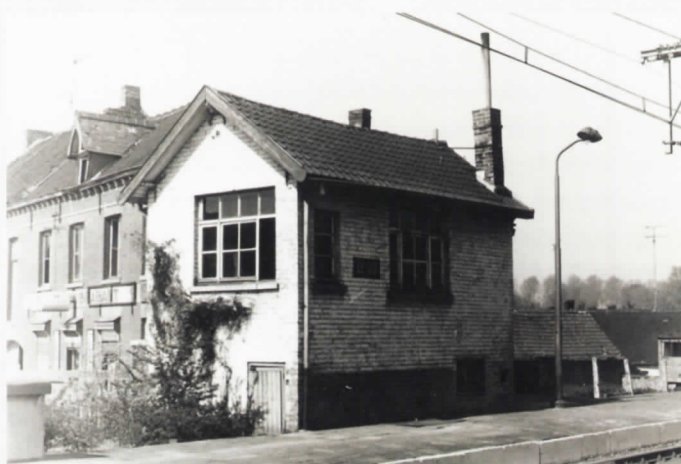
iii. 46 Aan het station van Oostkamp werd seinhuis 49 gebouwd. Deze blokpost lag langs de overweg aan de zijde van de Stationsstraat. Deze foto is na de elektrificatie van de spoorlijn gemaakt. We zien links ook al het muurtje van de voetgangerstunnel die begin jaren zestig werd aangelegd.
