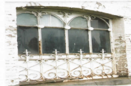
ill. 72-73 Detail van de smeedijzeren structuur van het zijraam van het wachthokje en de gietijzer zuiltjes voor de afbraak.
