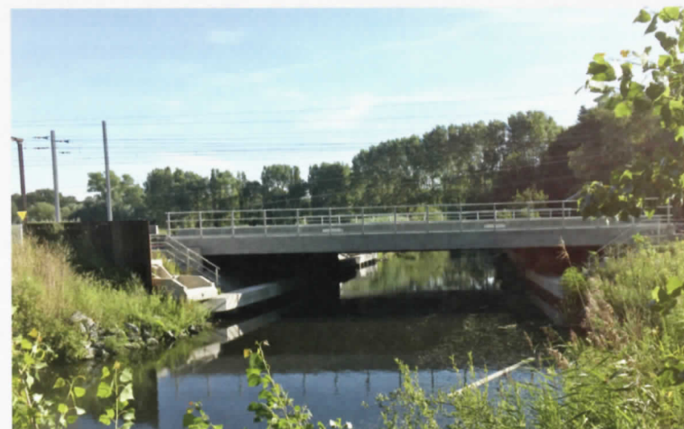
iii. 9 De brug over de Rivierbeek werd onlangs verbreed voor de aanleg van het derde en vierde spoor. Zowel links als rechts van de bestaande brug werd een bijkomende constructie voorzien.
