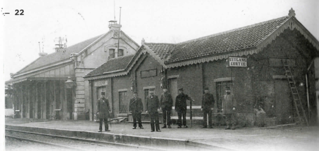
ill. 27 Het gebouw op de voorgrond is het tijdelijke station van Oostkamp uit 1865 dat volgens het gestandariseerd ontwerp van de spoorwegen werd gebouwd.
