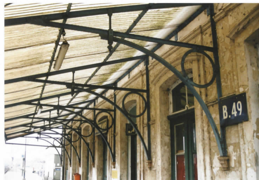
iii. 63 De ijzeren luifel aan het perron vóór de afbraak van het station.
