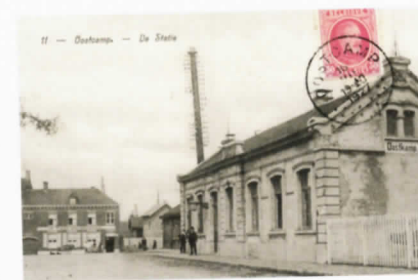
iii. 61 De voorzijde van het stationsgebouw. Op deze foto is het opschrift 'Oostcamp' op de zijgevel van het station al aangepast naar 'Oostkamp'. Aan de voorgevel werd de inkomdeur naar de wachtruimte van de derde klasse al dichtgemaakt en omgevormd naar een raam. Bemerkt centraal in de voorgevel het arduinen haltebord en de ijzeren topstukken op de dakpunten van de zijgevel.
